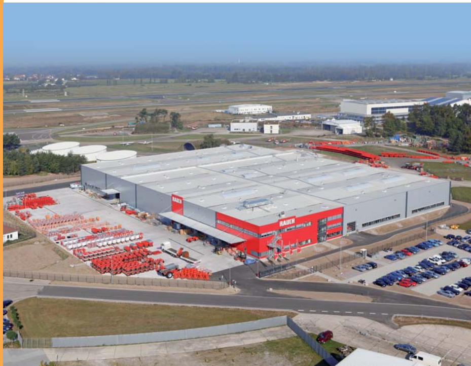
RAUCH-fabrik ved Baden-Airpark
