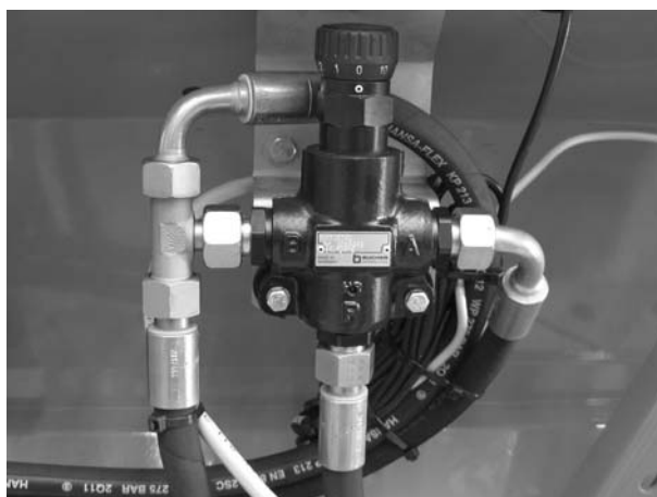
Figure 6.10 : Régulateur de débit
